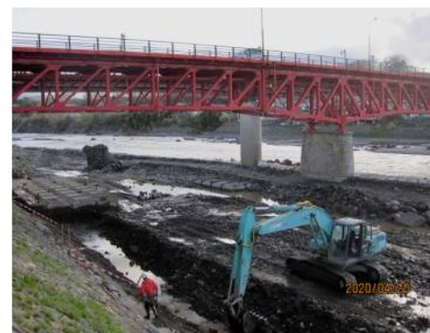
護岸工事と土砂撤去の進む千曲川
